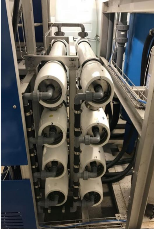
Figur 25 Spirallindade moduler.
