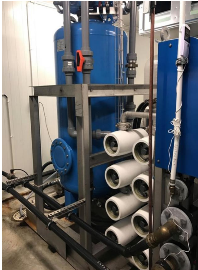
Figur 24 Ett sandfilter (blå tub), spirallindade moduler (vita tuber) och råvattenfilter (svarta tuber).
