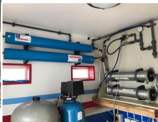
Figur 12 Fyra stycken rörformade membranfilter.
