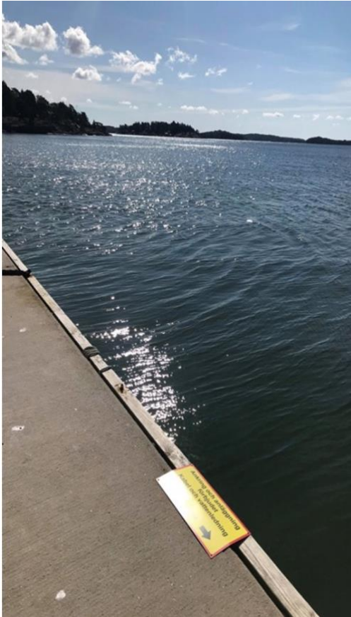
Figur 23 Bryggan där råvattenpumpen är placerad.
