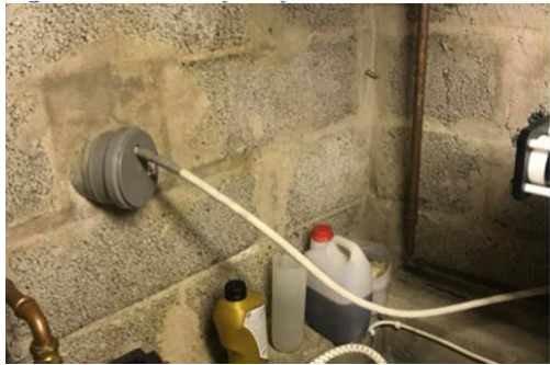
Figur 19 Utlopp för rejektvatten.
