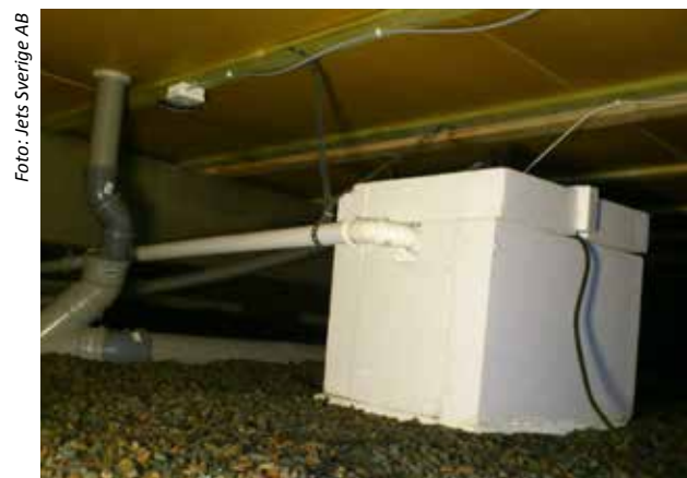
Isolerad vakuumenhet i kryppgrund.
