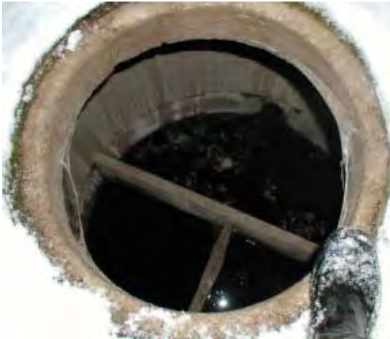
Figur 6. En slamavskiljare i form av en trekammarbrunn.
