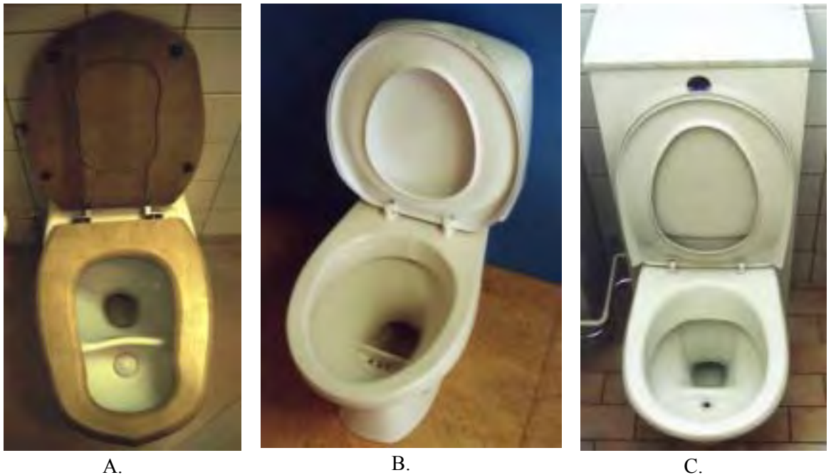
Figur 5. Olika modeller av urinsorterande vattentoalett. A. Dubbletten B. WostManEcology C. Gustavsberg.
