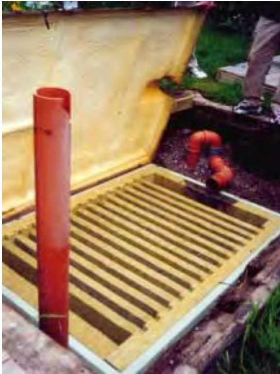
Figur 10. Exempel på innesluten filterbox med mineralull som filtermaterial..
