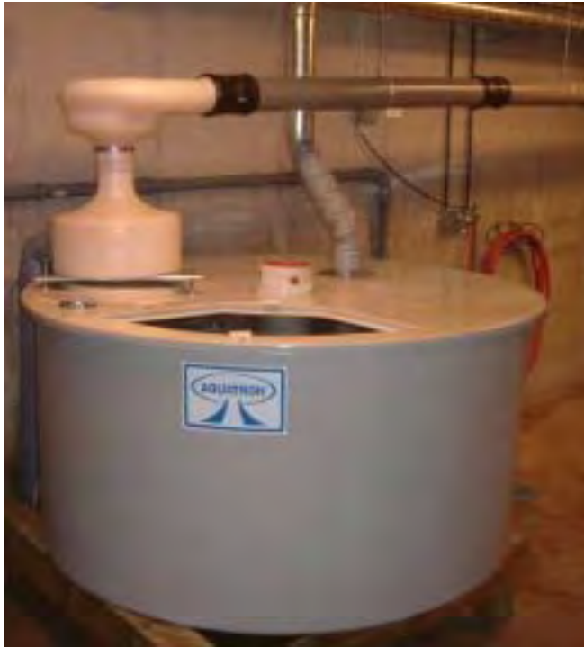
Figur 6. Separator för avskiljning av fekalier och toalettpapper ur avloppsvatten. Under finns en biokammare för fekaliekompostering.
